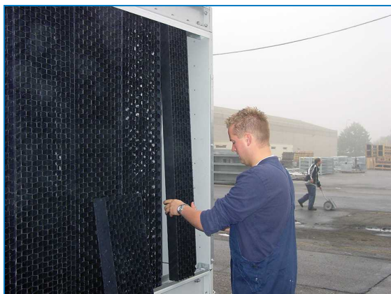
Снятие комбинированных щитов на входе
