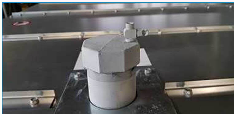
Резьбовое соединение теплообменника на льдоаккумуляторе
