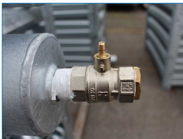
Conexiune superioară a serpentinei cu supapă de eliberare a presiunii pe turnuri de răcire cu circuit închis cu conexiuni mai mari de ND100.
