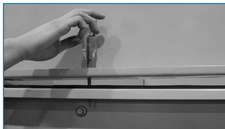
Utilizarea știftului de deriva pentru a alinia găurile pentru șuruburi
