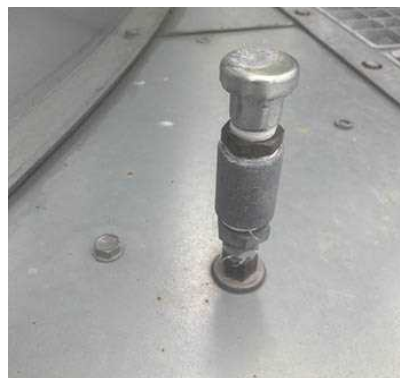
Luftningsanordning på fläktinsats
