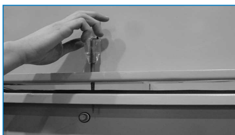
Användning av körnare för att passa in skruvhålen
