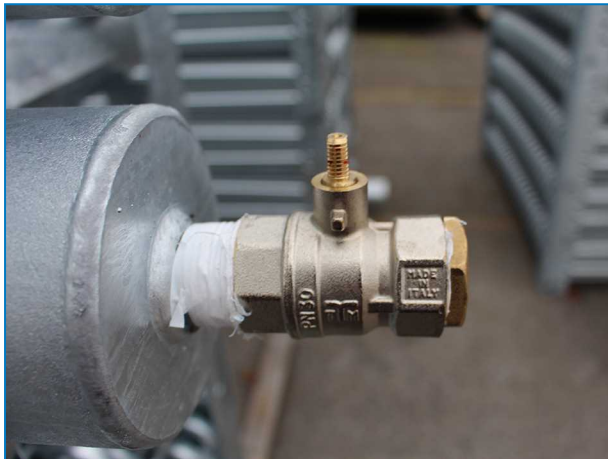
Bovenste batterijaansluiting met drukaflaatklep op koeltorens met gesloten kringloop met aansluitingen groter dan ND100.
