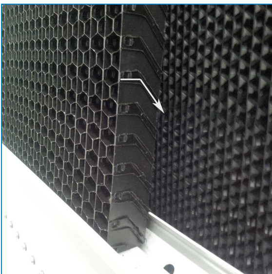
Demontering av kombinerade inloppspaneler
