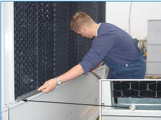
2. Um die kombinierten Lufteintrittsschutzelemente zu entfernen, heben Sie an und ziehen Sie an den unteren Enden.
