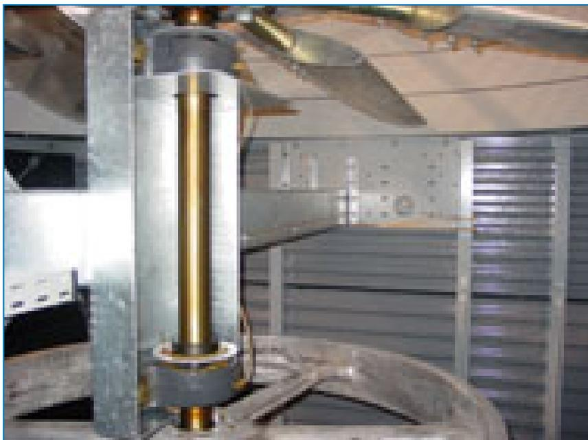
Las tuberías de engrase prolongadas con engrasadores pueden utilizarse para lubricar los rodamientos del eje del ventilador. Los engrasadores se encuentran en la zona del plenum situada junto a la puerta de acceso.
