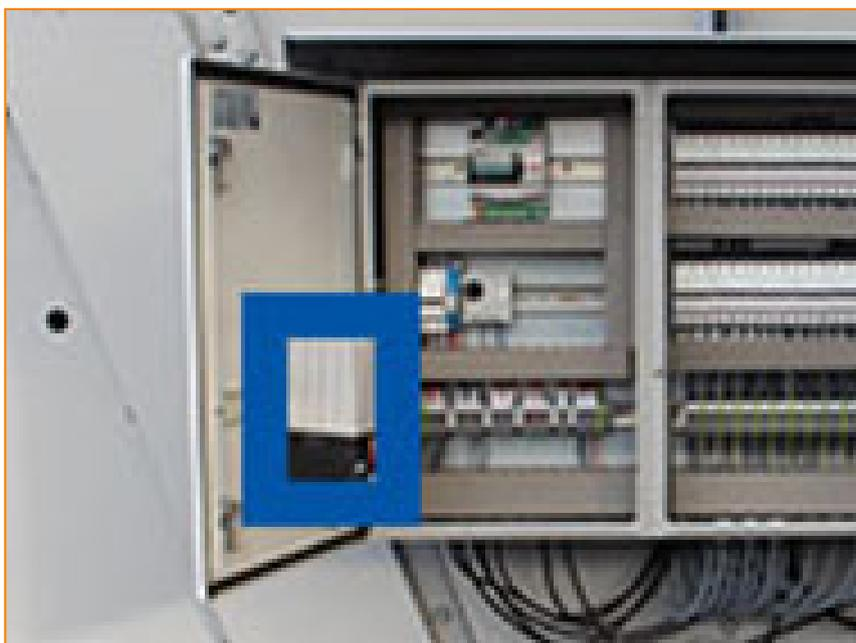
Il quadro elettrico è predisposto per essere installato in ambienti con temperature che raggiungono  $-10\text{ }^{\circ}\text{C}$ . Per climi dove la temperatura ambiente può essere ancora più bassa, un riscaldatore elettrico può prevenire danni ai componenti interni all'interno del quadro elettrico per temperature ambiente fino a  $-40\text{ }^{\circ}\text{C}$ .
