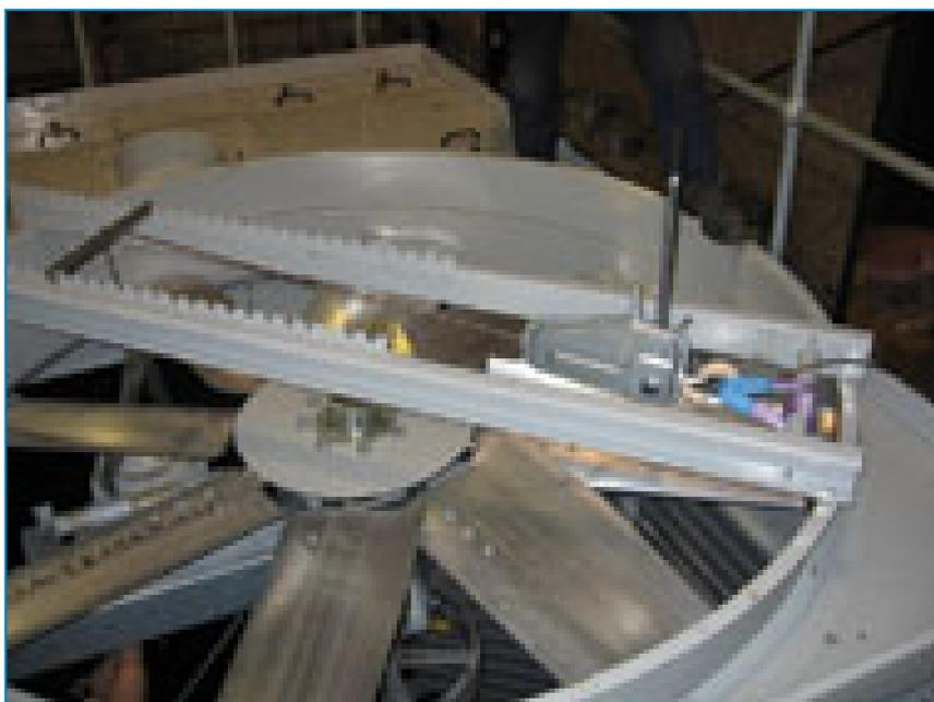
Установка легкой системы демонтажа механического оборудования поможет вам **легко** демонтировать или монтировать моторы вентиляторов или редукторы.
