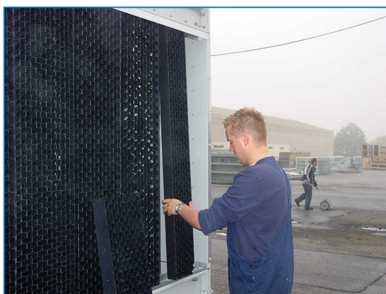
Снятие комбинированных щитов на входе
