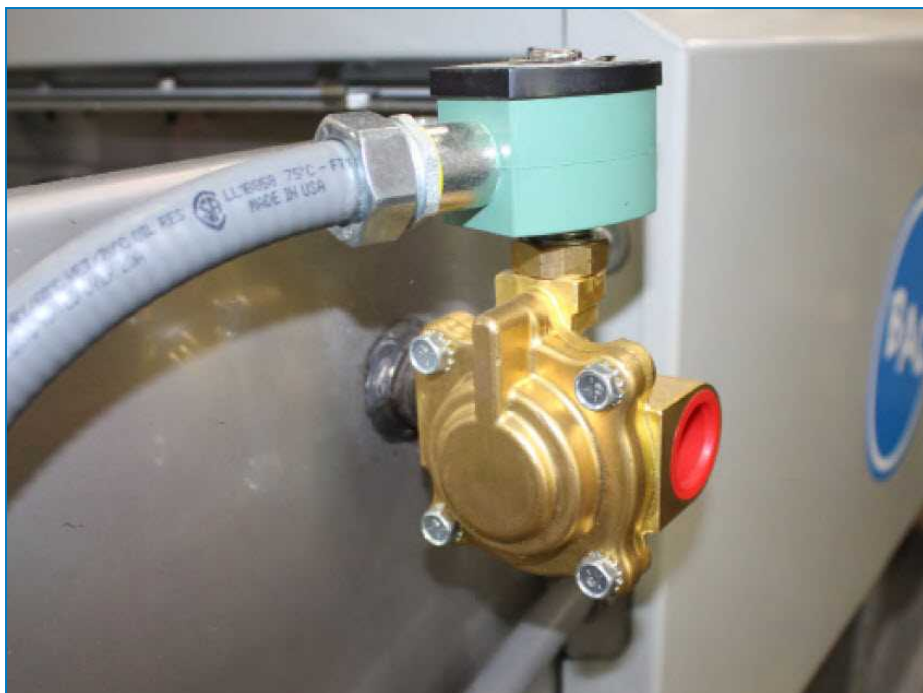
Электромагнитный клапан слива
