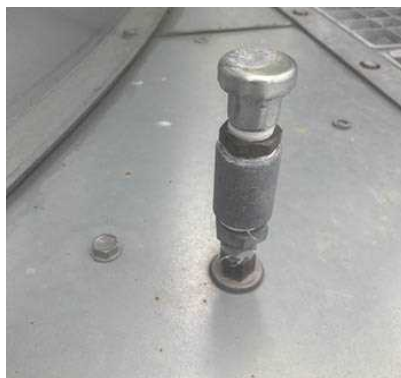
Airbreather an der Lüfterplattform
