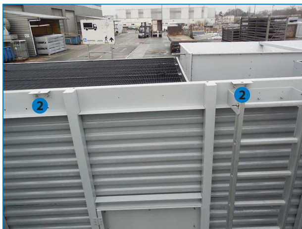
2. Aufstellführung/-klammer des unteren Teils
