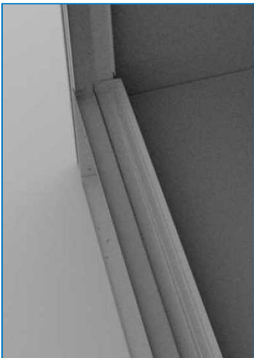
Canalón de recogida de agua
