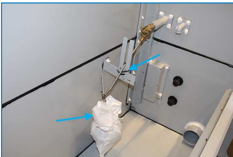
Befestigung und Umhüllung der Schwimmerkugel
